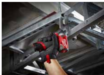
Der Schlagschrauber ›Fuel M12 FID-202X‹ kann dank seiner geringen Baugröße auf engstem Raum eingesetzt werden.
