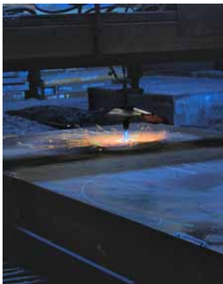
Mit bis zu 1500 Grad Celsius arbeitet sich die Gasflamme beim Trennvorgang durch das Material.
